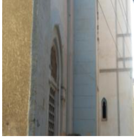
لوحة (١) الواجهة الشمالية الغربية لجامع العُمري ويتوسطها كتلة المدخل
